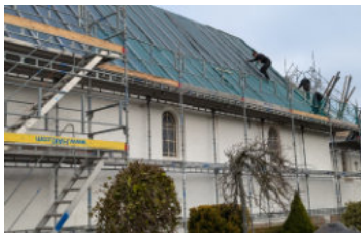
Sidst på året blev blytaget på Skæve Kirke fornyet, ved at man tog de gamle blyplader og smeltede om til nye.
