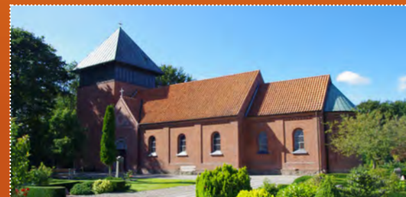
Badskær kirke · Ålborgvej 288 · 9352 Dybvad
