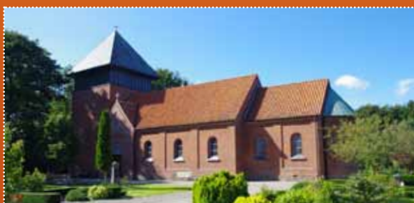
Badskær kirke · Ålborgvej 288 · 9352 Dybvad
