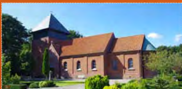
Badskær kirke · Ålborgvej 288 · 9352 Dybvad
