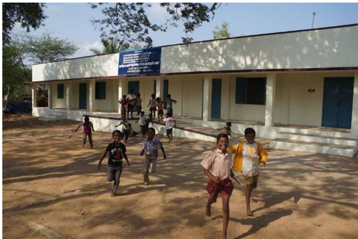
Skolebygningen med fire klasselokaler i Somasipadi, som er opført med midler fra Ejnar Skovsgaard Fonden
